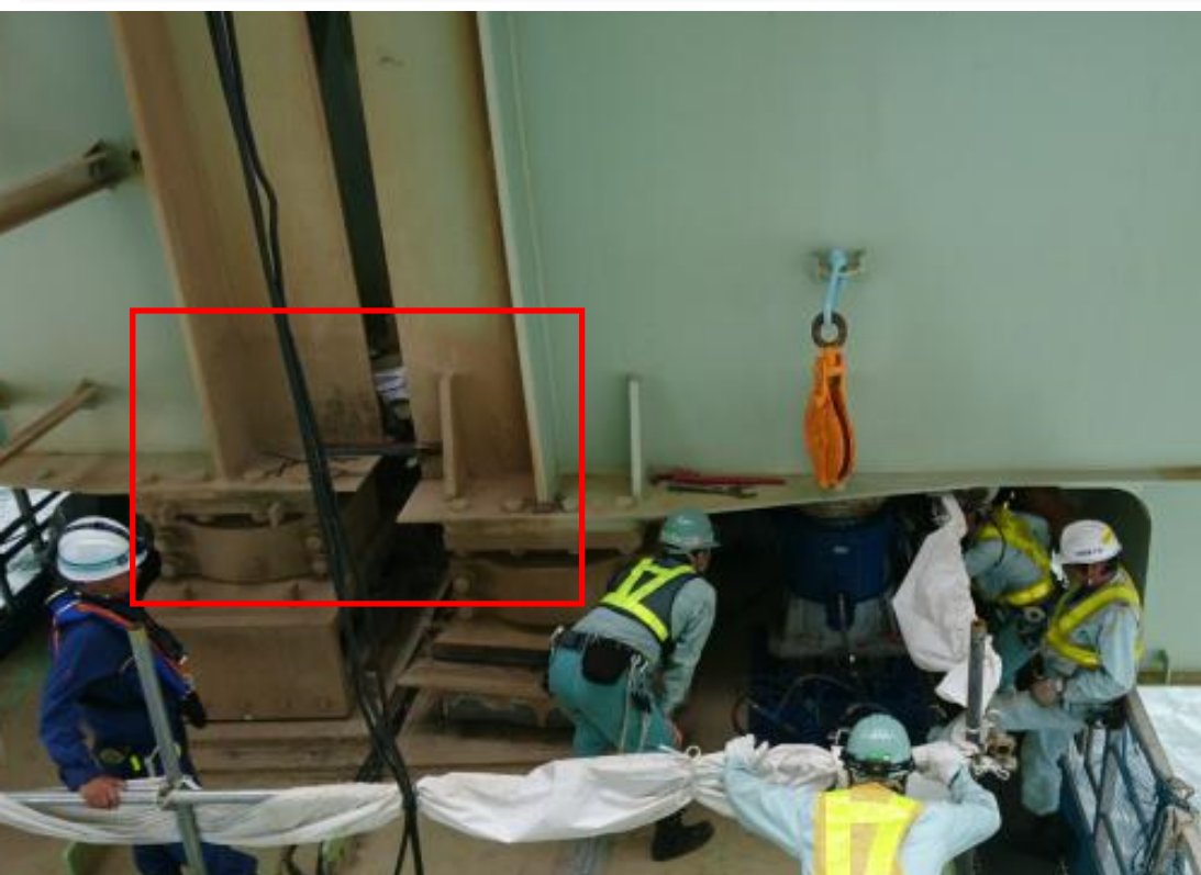
ジャッキアップ前 (9月14日 16時頃)
