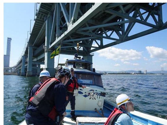
船上点検(関西国際空港連絡橋)
