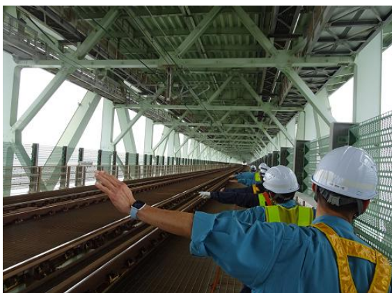
線路全線の巡回点検(関西国際空港連絡橋)
