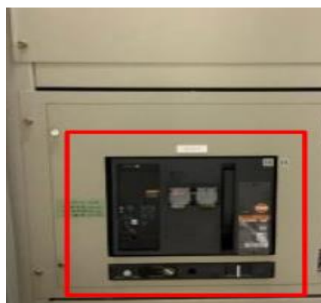
関西空港駅低圧遮断器取替
