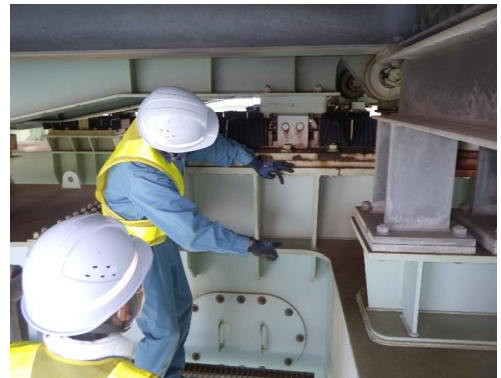
線路全線の巡回点検（連絡橋）
