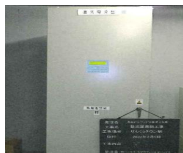
りんくうタウン駅直流電源装置更新
