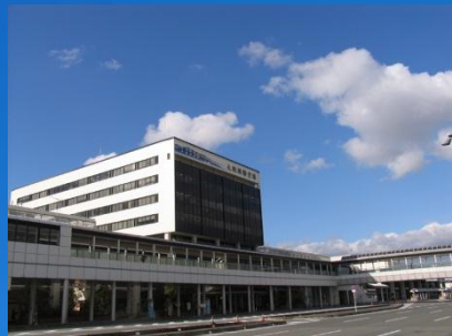
伊丹ターミナルビル
